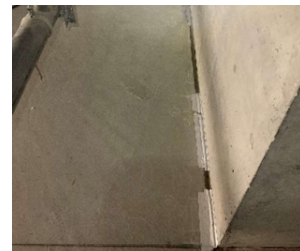
床・柱取合部
