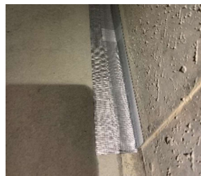
排水溝・壁取合部
