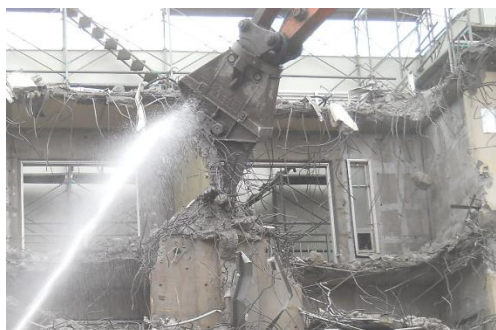
躯体解体中の散水の例
