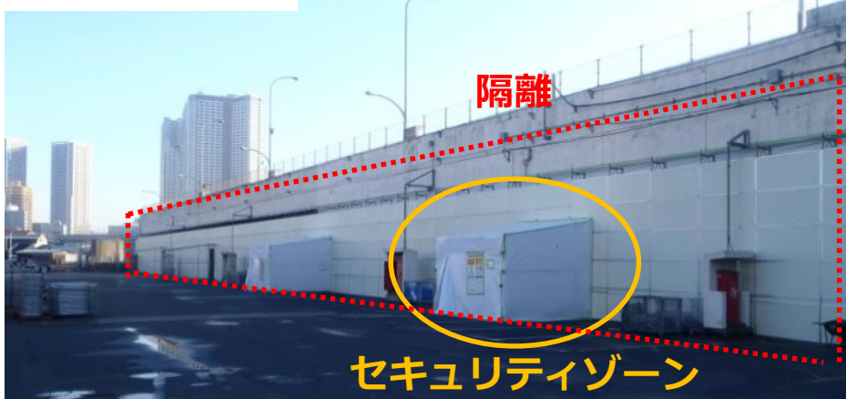
作業場所の隔離の例
