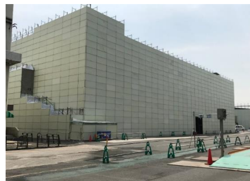
防音パネルの例
