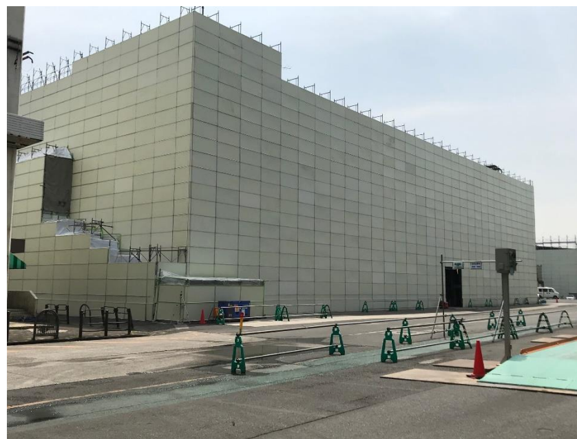
防音パネルの例
