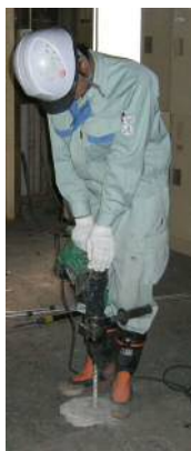
舗装部削孔 (ハンマードリル)
