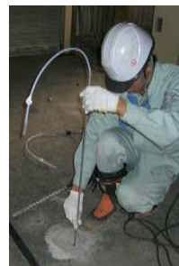
土壌ガス 採取管挿入
